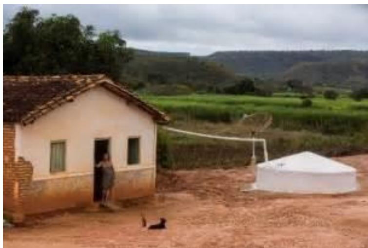
Figura 24 – Sistema de captação de água de chuvas implantado em uma residência na região semiárida brasileira.
