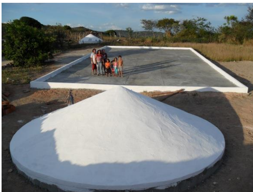
Figura 25 – Sistema de captação e de armazenamento de água das chuvas por meio de cisterna do tipo calçadão.
